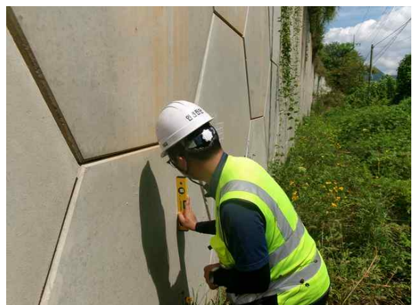
경사계를 이용한 경사도 측정
